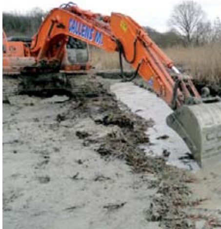
Travaux d'aménagements des rives © Virelles Nature
