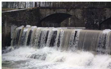
La débacle au pont barrage de St Roch
