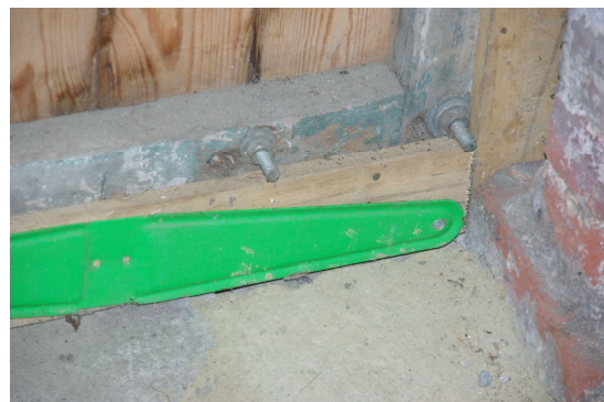
Photo 4 (ci-dessus) et 5 (ci-dessous) : Pièces métalliques utilisées derrière les portes pour réduire les accès aux rats.
