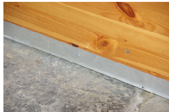
Photo 4 (ci-dessus) et 5 (ci-dessous) : Pièces métalliques utilisées derrière les portes pour réduire les accès aux rats.
