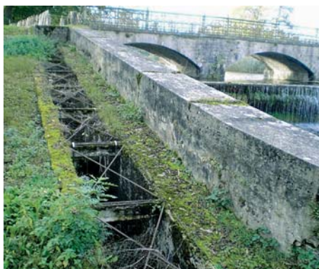
L'ancienne échelle à poissons ©P Roisin
