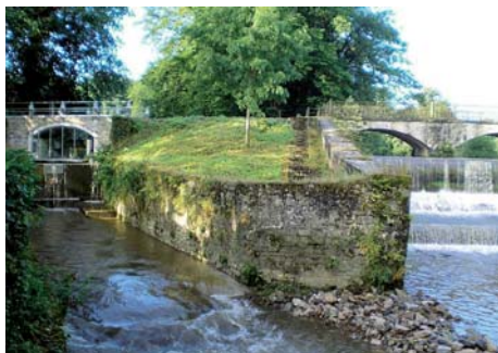
Vue de la turbine et du pont barrage © P. Roisin
