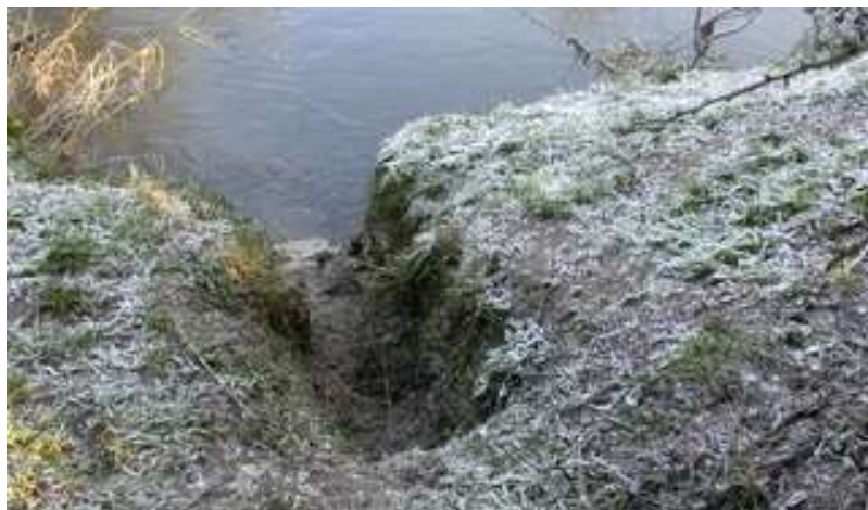
Photo 5 : Attention, la présence de ragondins a pour conséquence, par endroit, à devoir être attentif à bien éviter les accès à la berge qu'ils se sont aménagés. Thierry Dewitte, décembre 2022.
